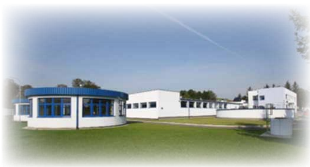
Stacja Uzdatniania Wody w Lubaszowej
